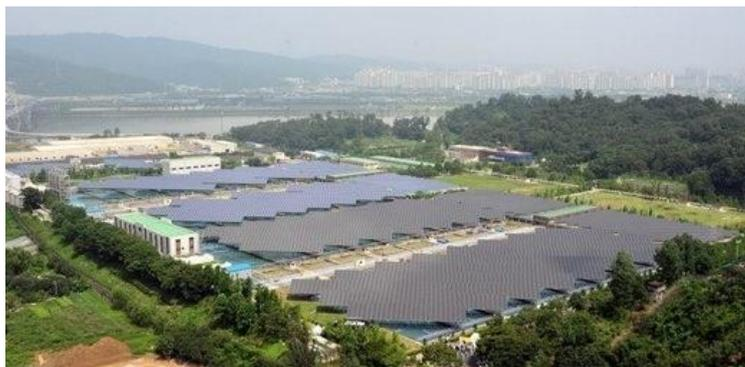
图 10. 建设于首尔市净水厂沉淀池上部的太阳光发电模块<sup>7</sup>
