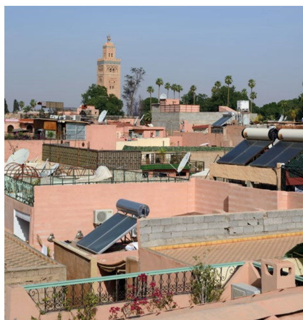
Des toits de Marrakech avec des panneaux solaires
